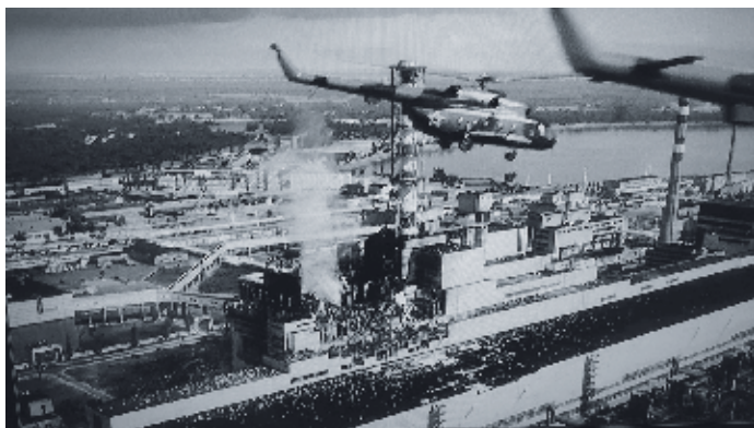
Аварія на ЧАЕС
