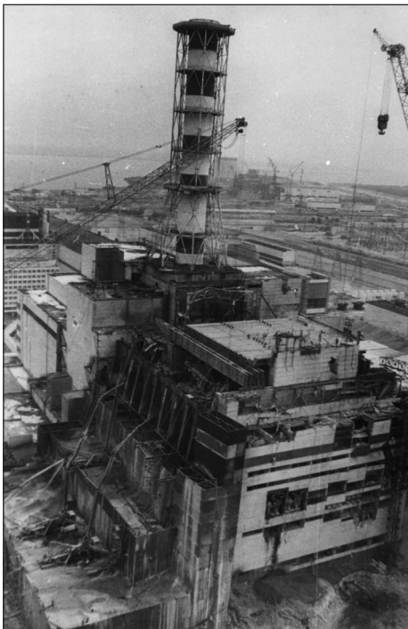
Будівництво об'єкту «Укриття». Фото ДСП Чорнобильська АЕС, chnpp.gov.ua .
