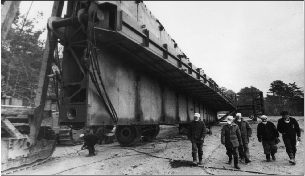
Будівництво об'єкту «Укриття». Фото ДСП Чорнобильська АЕС, chnpp.gov.ua .
