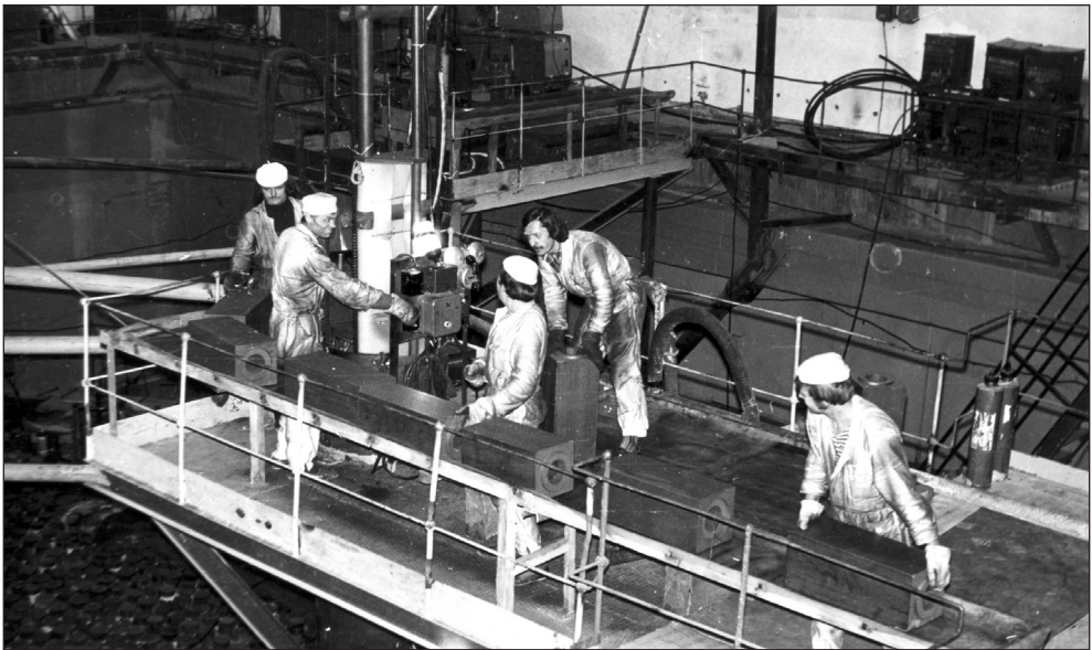
Монтаж графітової кладки. Фото ДСП Чорнобильська АЕС, chnpp.gov.ua .
