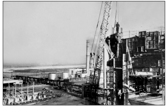
Будівництво Чорнобильської АЕС, січень 1975 р. З фондів Укрінформу.
