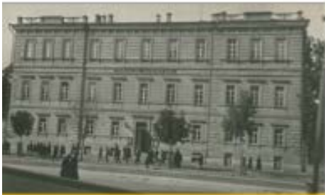
Будівля Української Академії наук. Київ, вул. Велика Володимирська, 54. 1919–1921 роки
