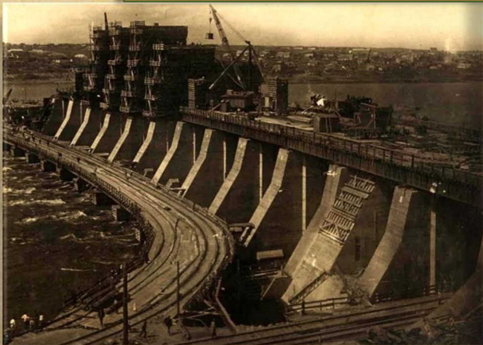
Спорудження Дніпровської ГЕС. Фото 1930 року
