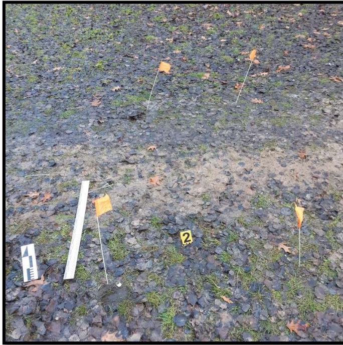
Фото № 8. Межі запланованого шурфу № 2
